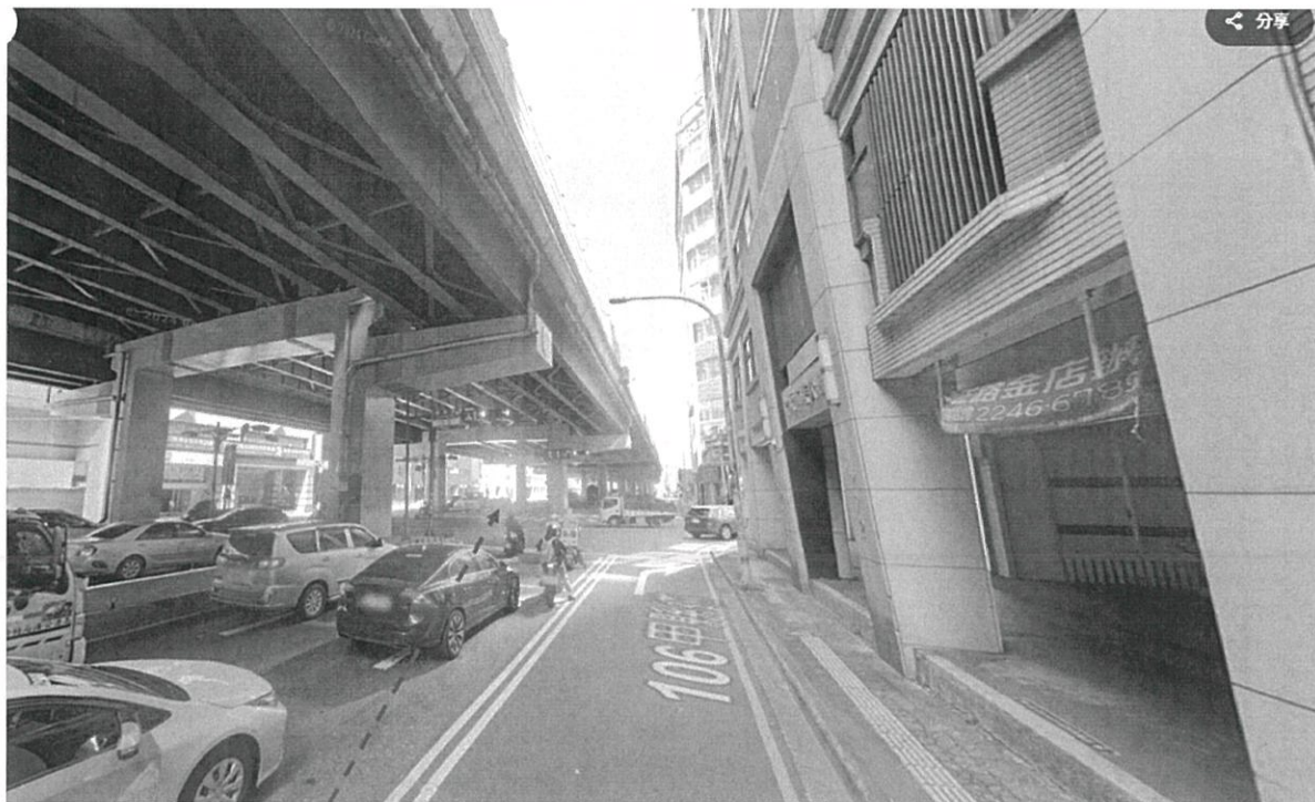
於中正建康路口 接回內側車道
